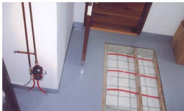
FOTO: VISTA DEL CALENTAMIENTO DE ESPACIOS POR ENERGIA SOLAR EN LAS OFICINAS, EN BOGOTÁ.
